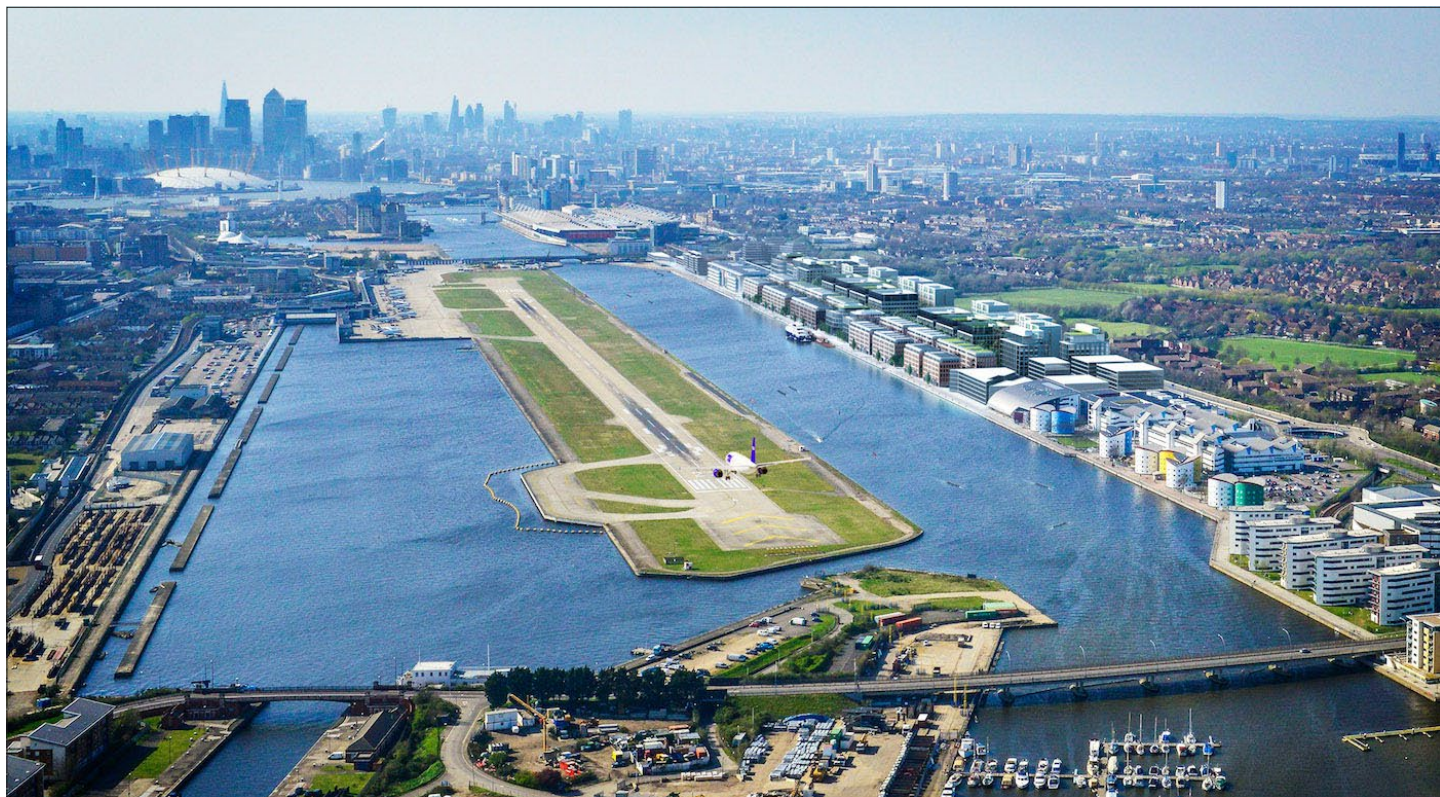
Royal Albert Dock -hankkeen asunoneliöt on sijoitettu alueen pohjoispuolelle lentomelun minimoimiseksi. Projekti näkyy kuvassa Thamesin oikealla rannalla.
